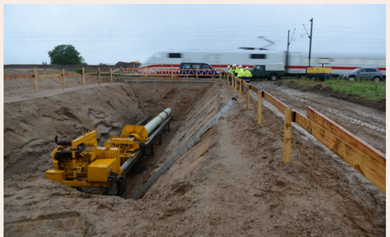
Bild 2: Neun Bohrpressungen zur Unterquerung von Straßen und Bahnlinien wurden durchgeführt Quelle: terranets bw
